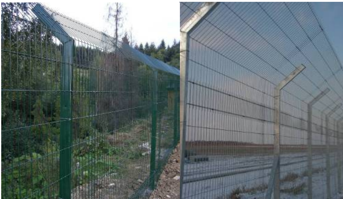
Рис. 1 – Ограждение с полимерным покрытием (слева) и без полимерного покрытия
