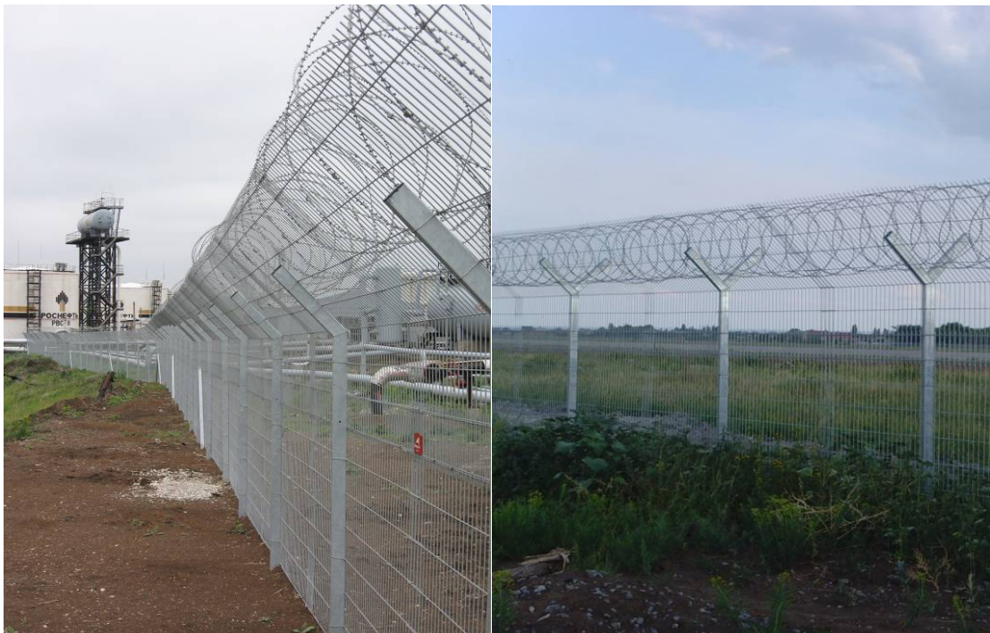
Рис. 8 – Ограждения с армированной колючей лентой
